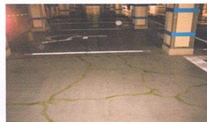
【ひび割れ充填状況】
