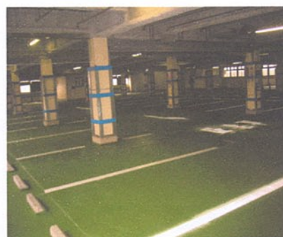
【表面仕上げ完了】
