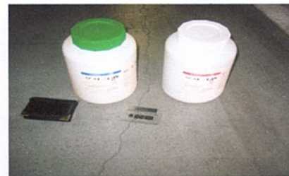
【床表面ひび割れ発生状況】
